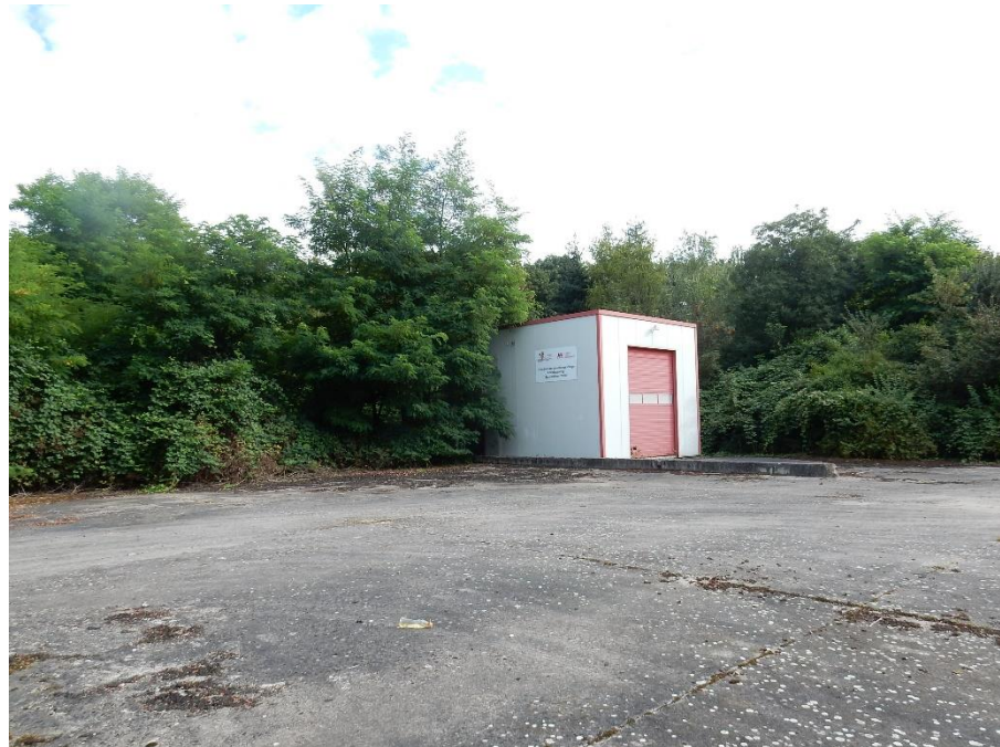
Foto 1: Grundwassersanie- rungsanlage Altablage- rung „Eppelheimer Wald“
