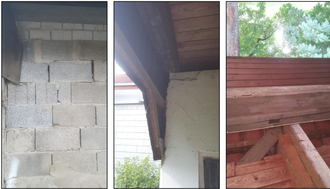
Foto 17: Potenziell geeignete Spaltenquartiere an den im Untersuchungsgebiet befindlichen Gebäuden (links: Spalten im Mauerwerk; Mitte: Übergangsbereich Mauerwerk und Dachbalken; rechts: Spalten in den Holzbalken).
