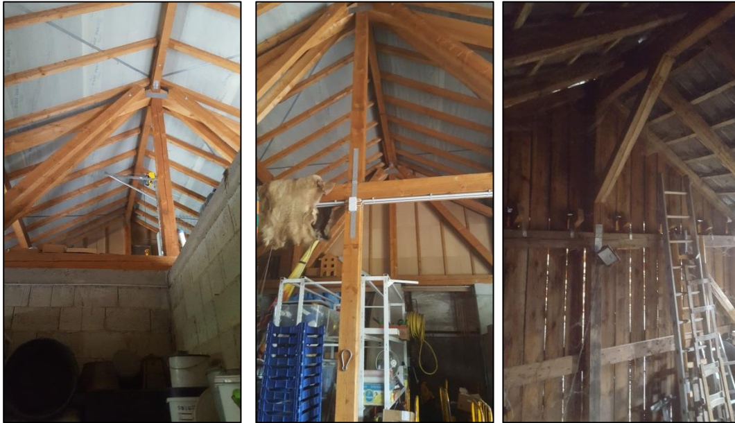
Foto 19: Beispiele für die Innenbereiche der Gebäude im Untersuchungsgebiet.
