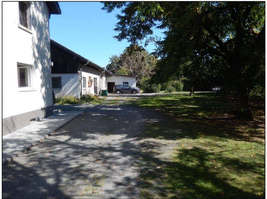
Foto 2: Der Einfahrtsbereich des Wohnhauses (links im Bild), dahinter das Werkstattgebäude.
